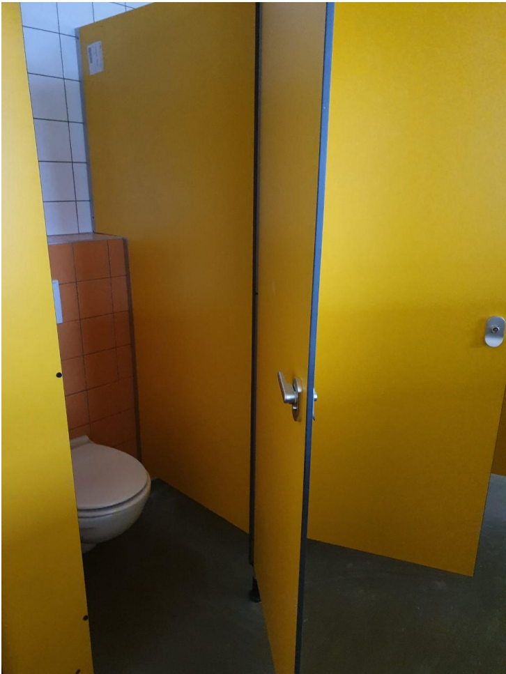
De vloer in de aula en gangen is geëgaliseerd. Toiletdeuren zijn vervangen in de toiletunit bij groep 1-2 en groep 4. The floor is equalized and toilet doors are replaced.
